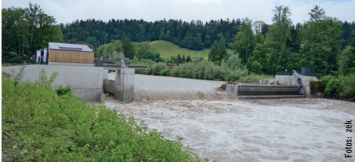
Die Stauklappen messen 23 x 2,7 m. Im Hochwasserfall werden sie in Minutenschnelle umgelegt und der Kraftwerksbetrieb eingestellt, damit der freie Geschiebetrieb möglich wird.
