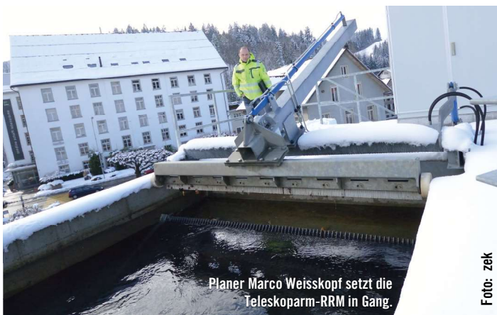
Der bestehende Oberwasserkanal wurde zur Gänze saniert, das alte Trapezprofil musste einem rechteckigen weichen.
