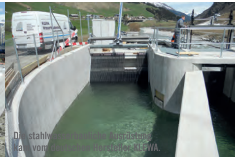
Die Arbeiten an der Fassung mit dem Sandfang sind weit gediehen.
