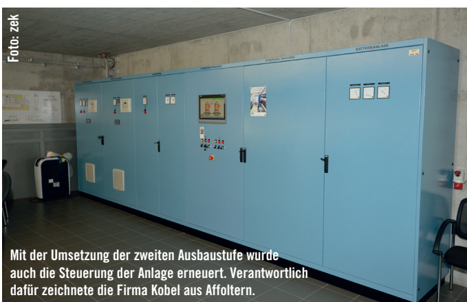
Auf Wunsch der Betreiber wurde die Visualisierung von Kobel so konzipiert, dass auf dem großen Kraftwerkspanel stets beide Maschinensätze parallel nebeneinander zu sehen und alle Parameter einfach vergleichbar sind.
