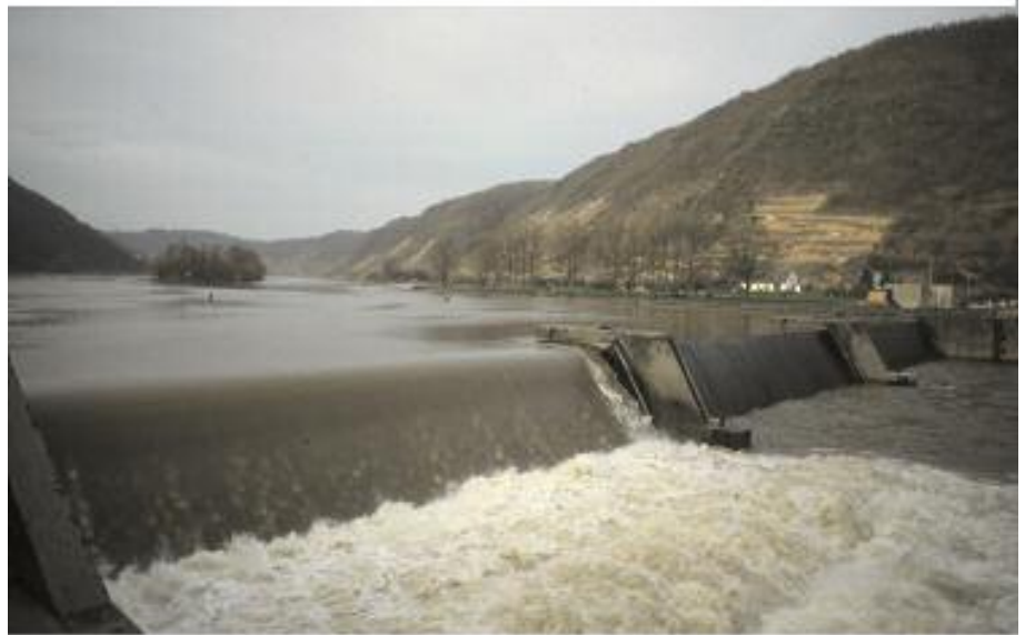
Bild 3.8: Sektorwehr der Mosel- staustufe Lehmen (Rheinland-Pfalz)
