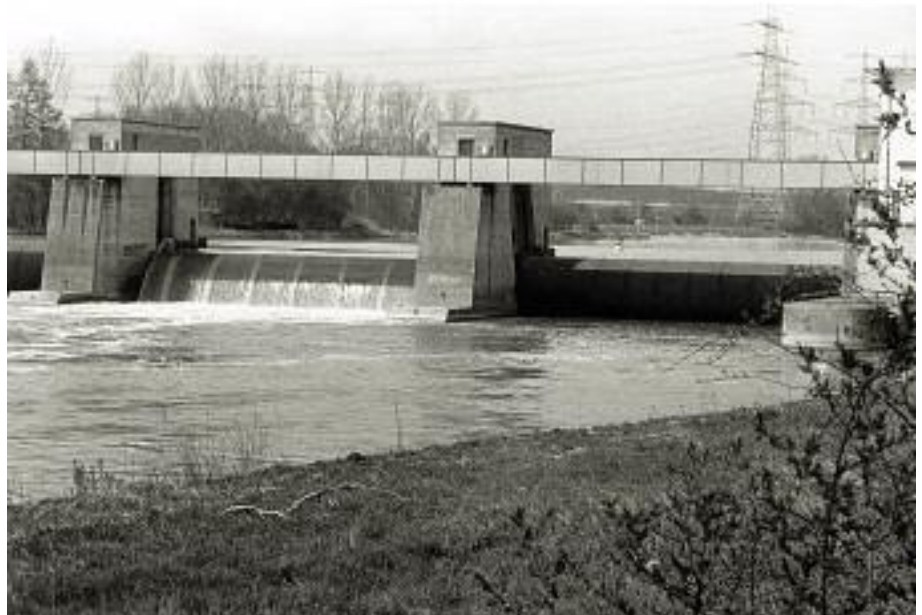
Bild 3.7: In die Außenfelder des Wehres der Mainstau- stufe Garstadt (Bayern) sind Walzenverschlüsse eingesetzt, im Mittelfeld ein Schütz mit aufgesetz- ter Stauklappe
