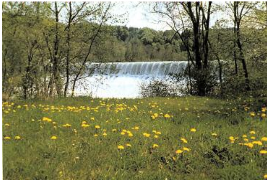
Bild 3.17: Überflutbares Wasserkraftwerk Lechblick am Lech (Bayern)
