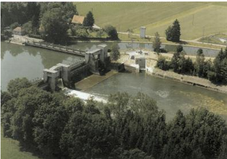
Bild 3.20: Einlaufbauwerk Illerkanal am Wehr Mooshausen (Baden-Württemberg)
