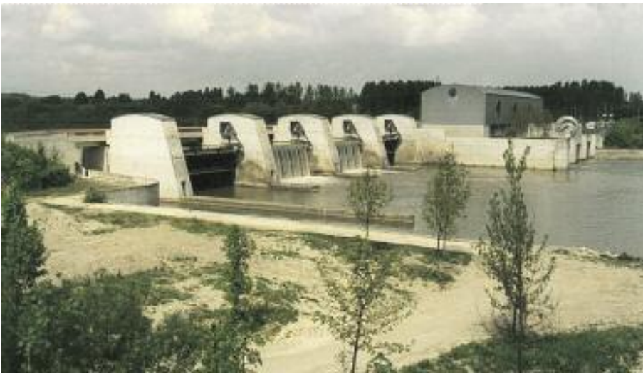
Bild 3.10: Donaustaustufe Vohburg (Bayern): Zugsegmente mit aufge- setzter Stauklappe
