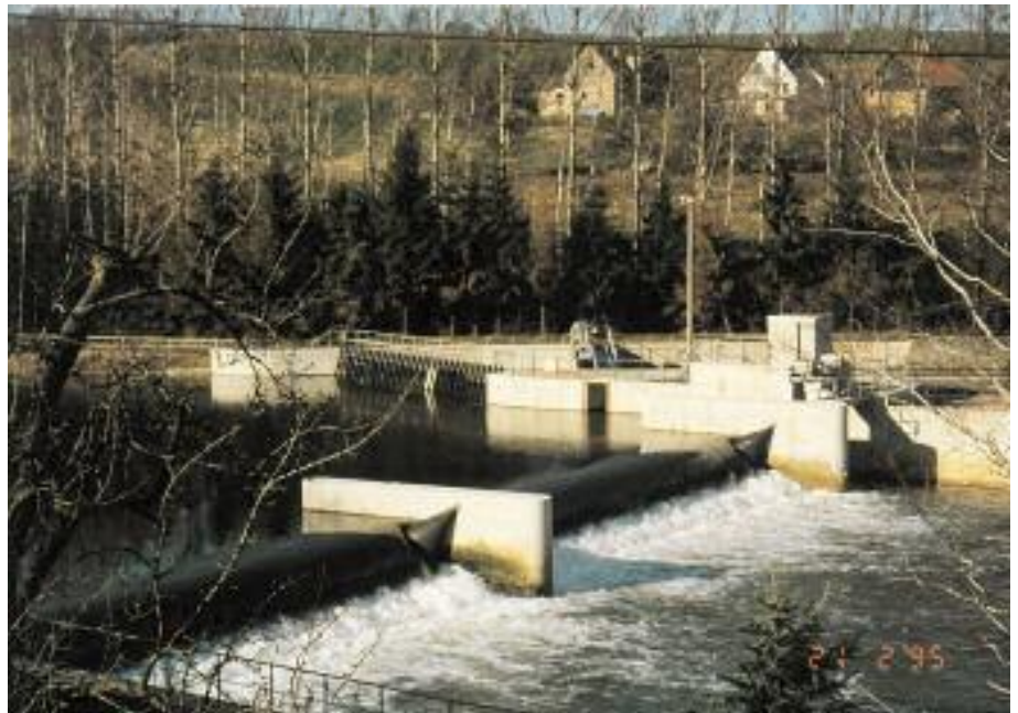
Bild 3.12: Schlauchwehr Thierbach an der Zwickauer Mulde (Sachsen)
