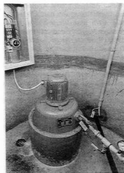
Abb. 5 Peltonturbinen in vertikaler Bauweise (Minianlage mit 800 Watt).
