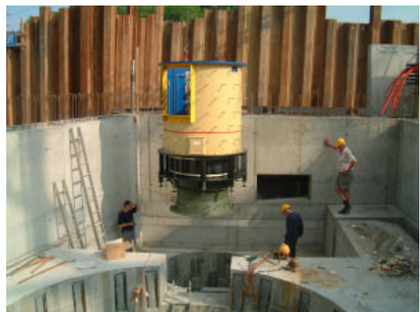
Bild 7: Montage Dotierturbine als Compacteinheit
