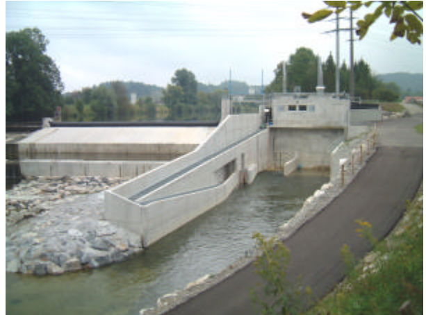
Bild 9: Ansicht von Unterwasser mit Fischaufstieg
