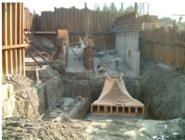
Bild 6: Bauzustand: Saugrohrschalung Hauptturbine
